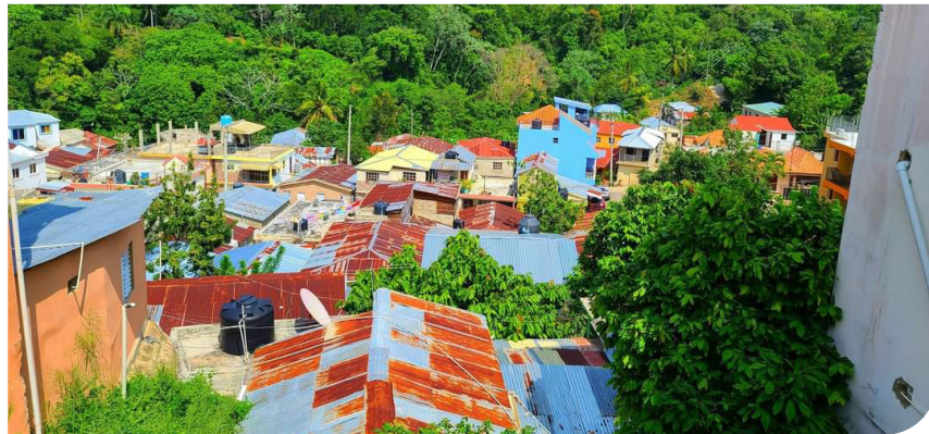
Vista parcial de un sector del casco urbano del Municipio.
